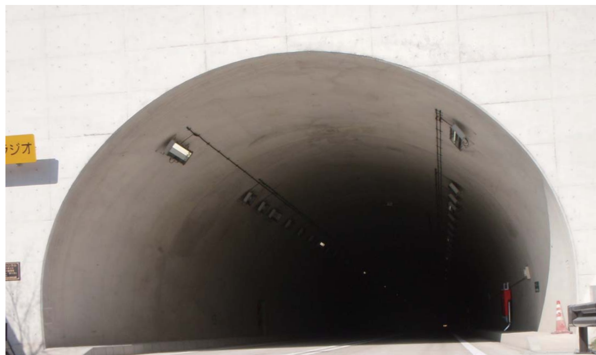
満口田万里トンネル
