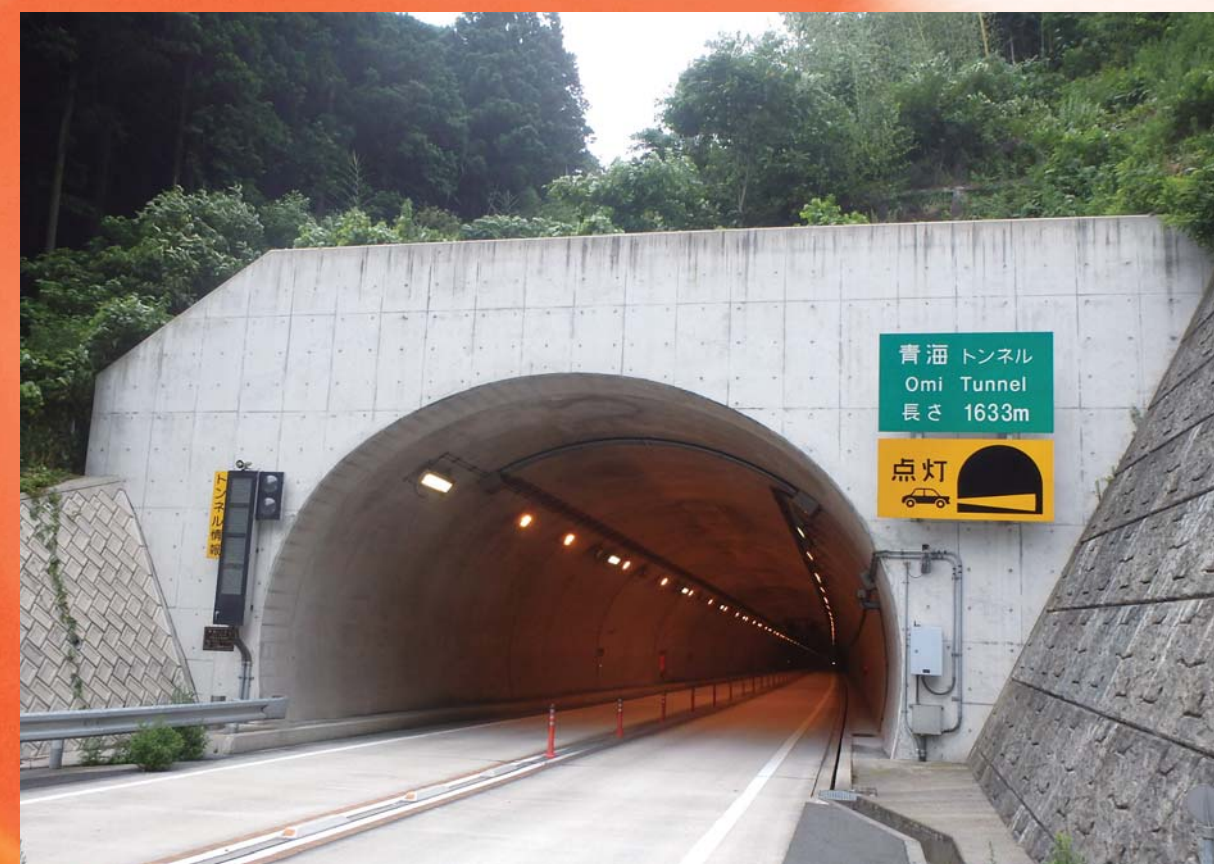
青海トンネル
