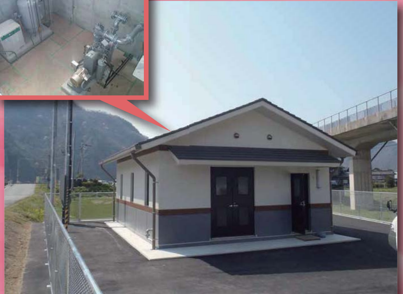
兵庫県西播磨県民局 苅縄取水ポンプ室
