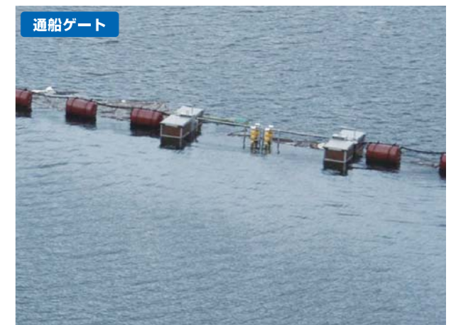
広島県東広島地域事務所(福富ダム)
