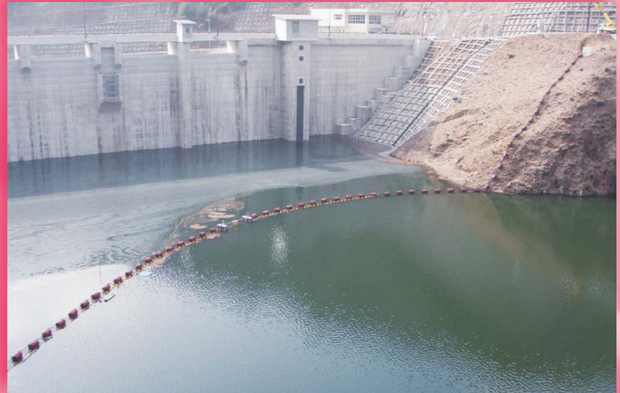
広島県西部建設事務所
