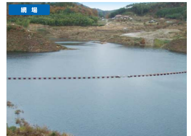
広島県東広島地域事務所(福富ダム)
