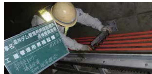
温井ダム・管理用昇降設備
