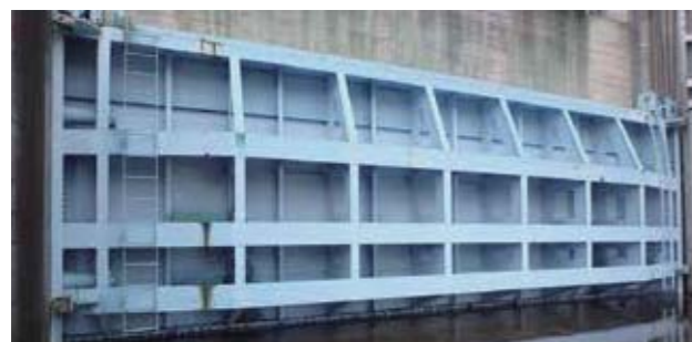
島根県浜田県土整備事務所管内・田原川樋門
