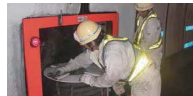
長府トンネル・消火設備
