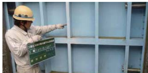
太田川河川事務所管内・小型樋門
