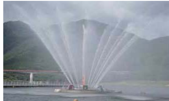
土師ダム・噴水設備
