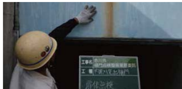
島根県雲南県土整備事務所管内・小型樋門
