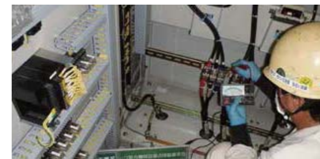
防府第3トンネル・換気設備
