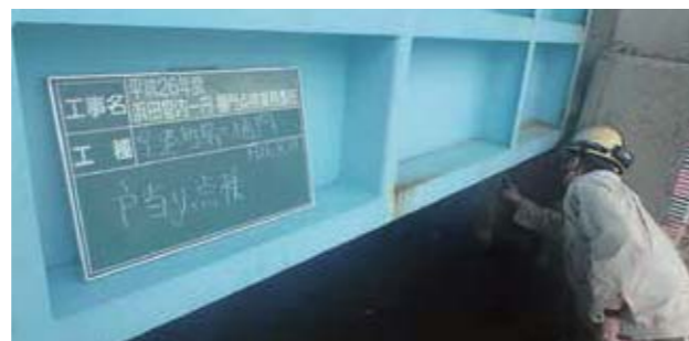
島根県浜田県土整備事務所管内・小型樋門
