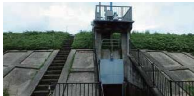
山形河川国道事務所管内・小型樋門
