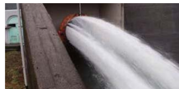
棕梨ダム・放流設備
